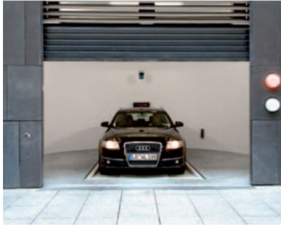
Рисунок 2.8 – Приклад приймального приміщення для механізованого паркінгу
