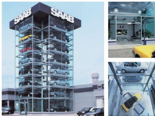
Рисунок 2.10 – Механізований гараж для зберігання автомобілів SAAB
