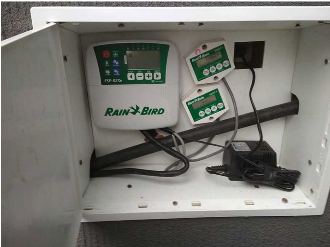
Рисунок 2.5 - Американська система крапельного поливу Rain Bird с датчиками параметрів ґрунту Rain Bird SMRT-Y
