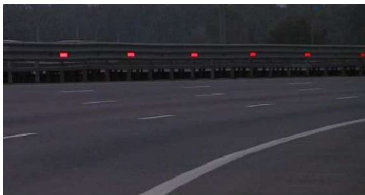
Рис. 3.12 – Влаштовані експериментальні світлоповертальні елементи
