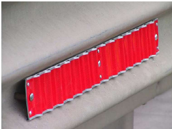
Рис. 3.11 – Запропонований світлоповертальний елемент
