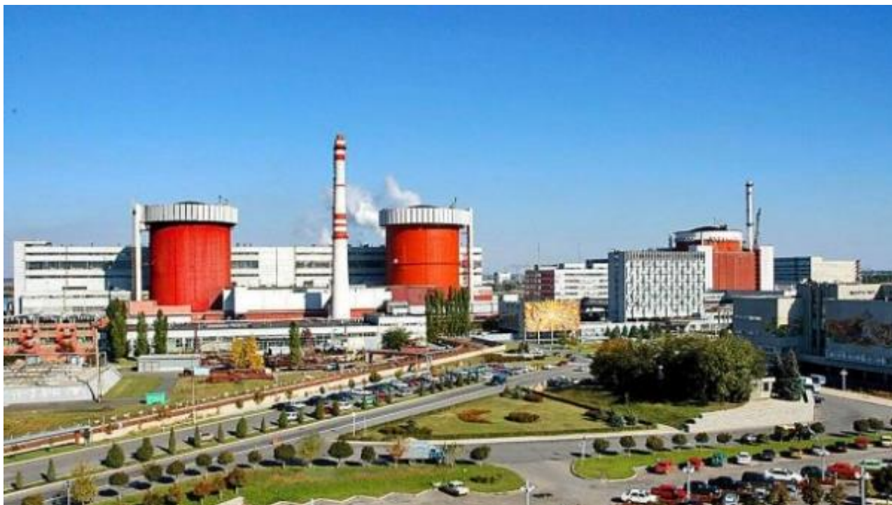
Рисунок 1.1 – Південноукраїнська атомна електростанція
