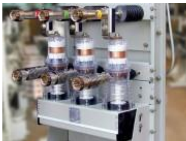
Рисунок 2.2 – Вакуумний вимикач марки ВВ/TEL-10-20/1000У2
