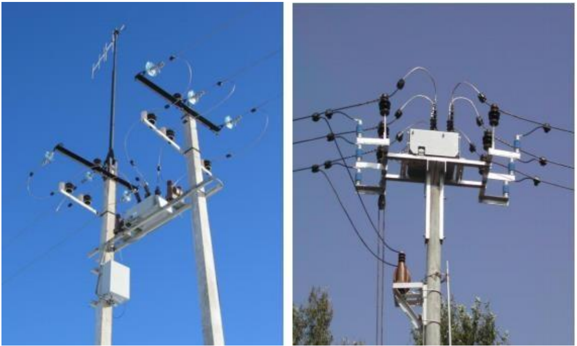
Рисунок 1.1 – Реклоузер вакуумний типу PVA/TEL-10-12,5/630
