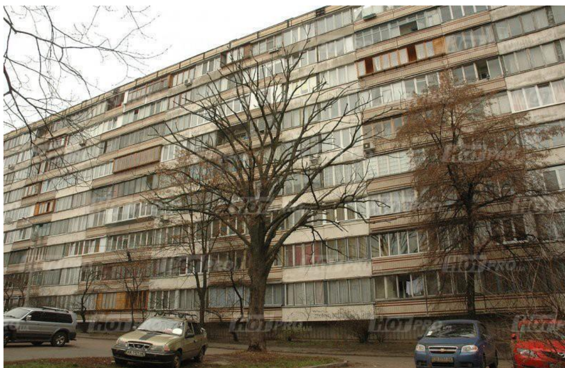
Рисунок 2.1 – Загальний вигляд житлового будинку.
