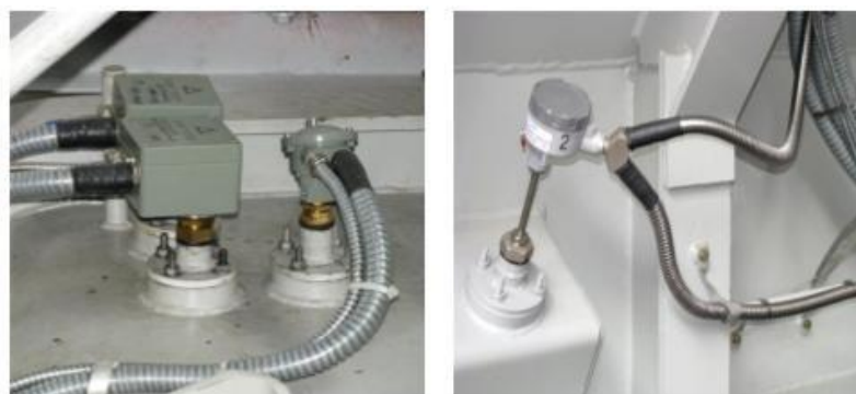
Рисунок 2.11 – Вимірювачі температури виробництва ПАТ «ЗТР»
