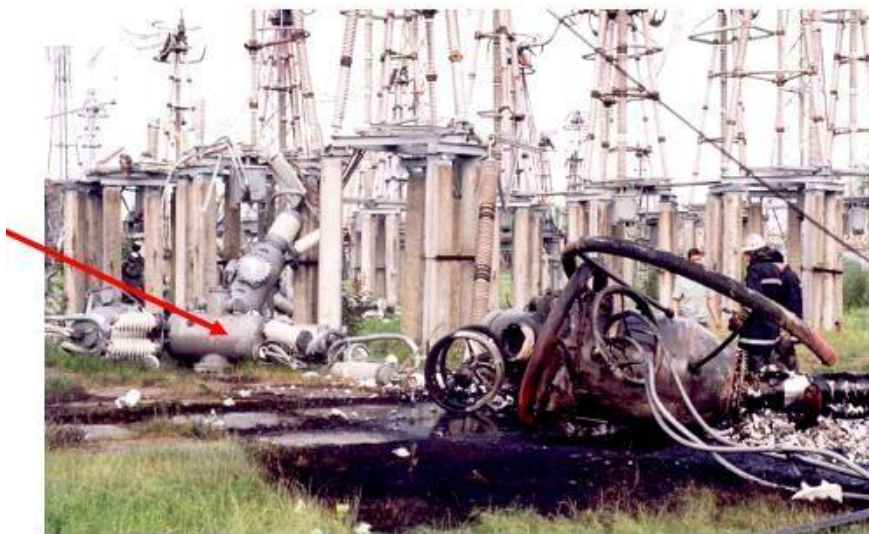
Рисунок 4.2 - Пошкоджений повітряний вимикач
