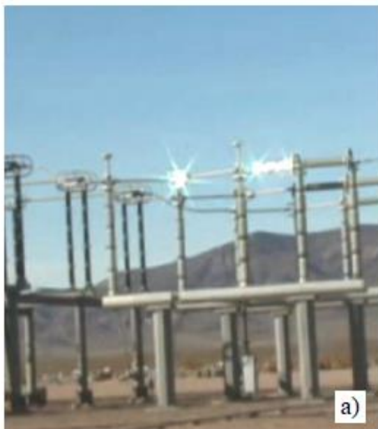
Рисунок 7.1 – Електрична дуга, яка виникла на полюсі роз'єднувача під час аварійної ситуації в розподільному пристрої високовольтної підстанції (а), згодом набуває загрозливих розмірів (б)
