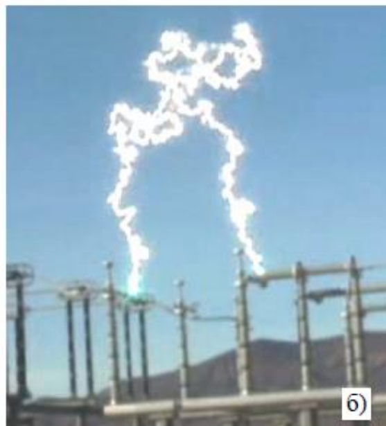
Рисунок 7.1 – Електрична дуга, яка виникла на полюсі роз'єднувача під час аварійної ситуації в розподільному пристрої високовольтної підстанції (а), згодом набуває загрозливих розмірів (б)
