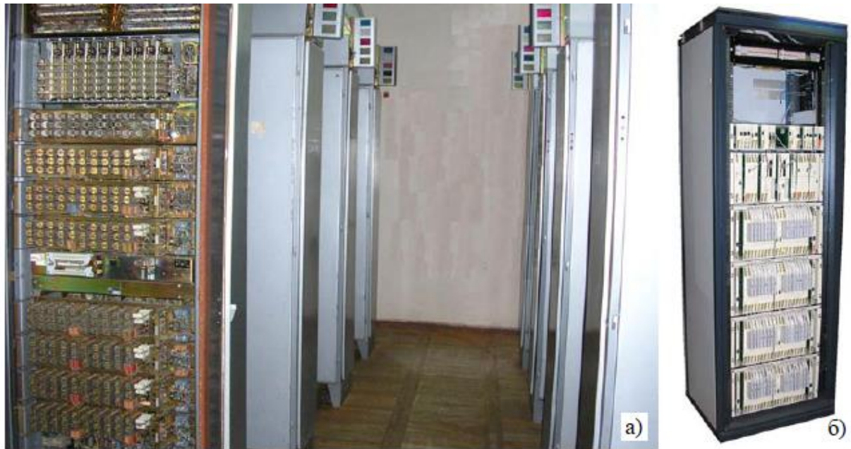
Рисунок 6.7 – Електромеханічна (а) та цифрова (б) АТС
