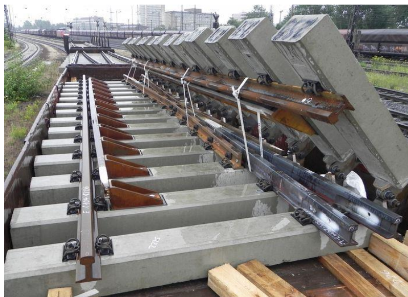
Рис.1.3.Транспортування розкладних блоків стрілочних переводів
