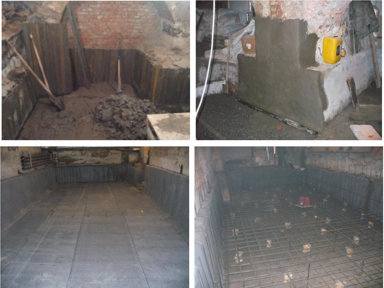
Рисунок 2.2 – Комплекс робіт по зниженню підвалу на об'єкті №2
