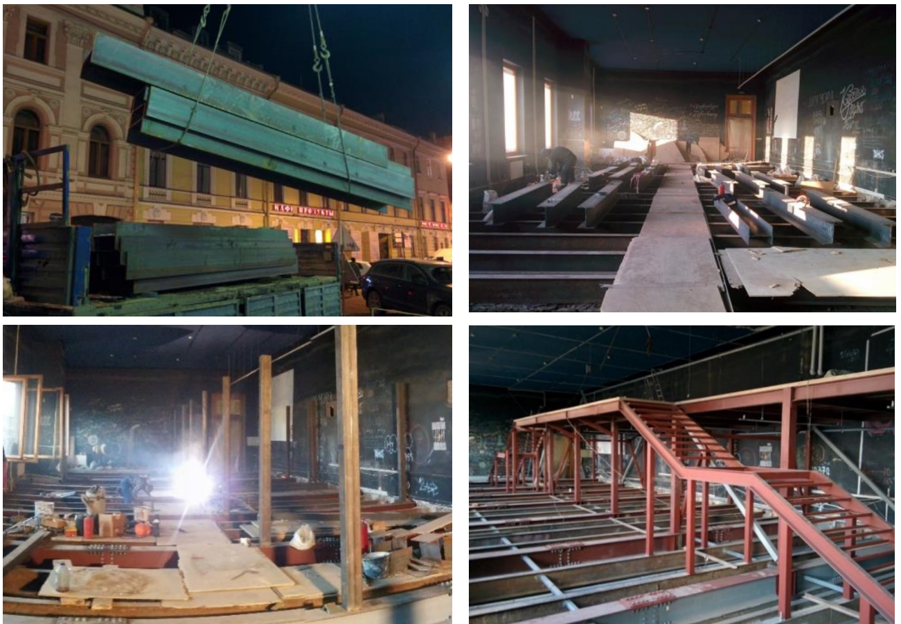
Рисунок 2.1 – Процес виробництва робіт по влаштуванню металеві антресолі на об'єкті ТРК
