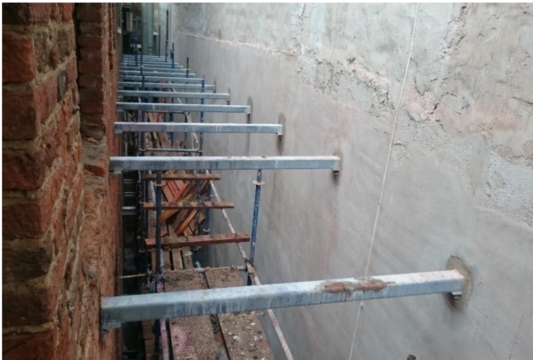
Рисунок 2.4 – Зведення несучих балок скляного козирка
