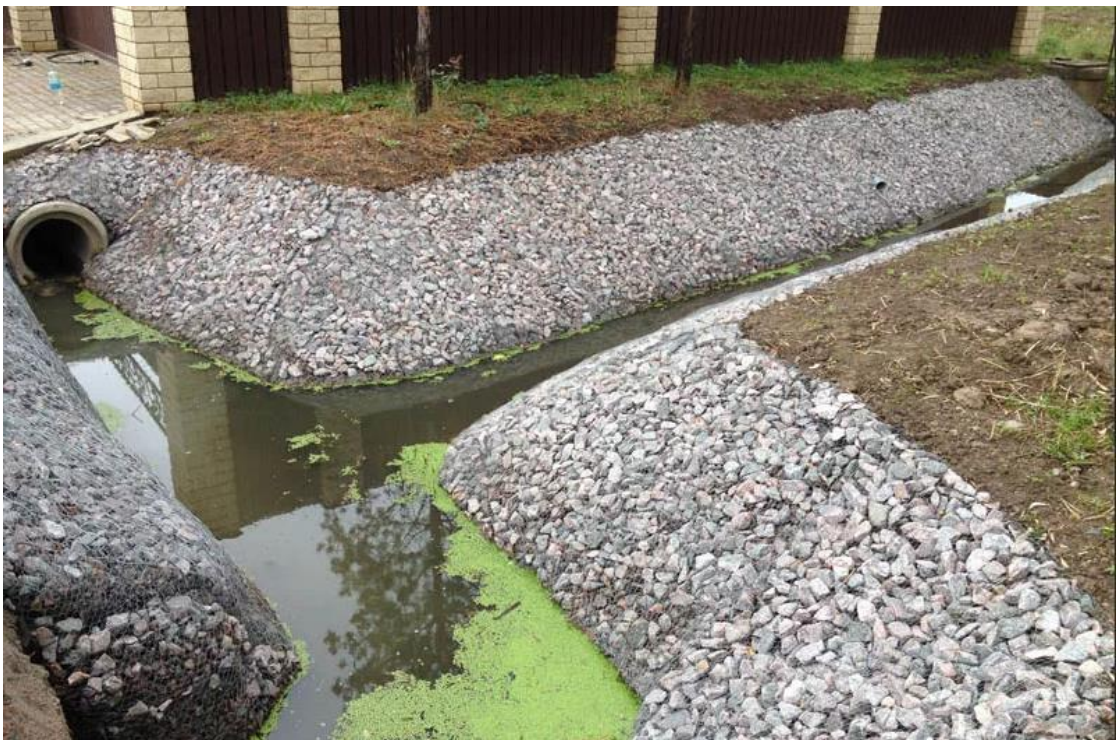
Рисунок 3.7 – Приклад укріплення каналів
