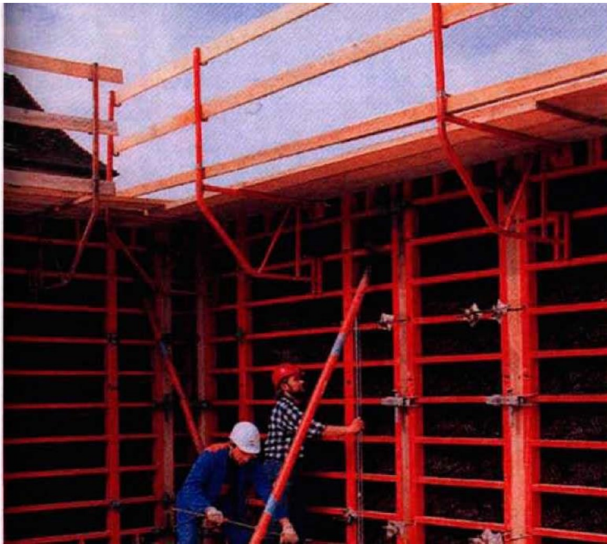
Рисунок 1.10 – Розбірно-переставна опалубка «PERI» (TRIO 330)
