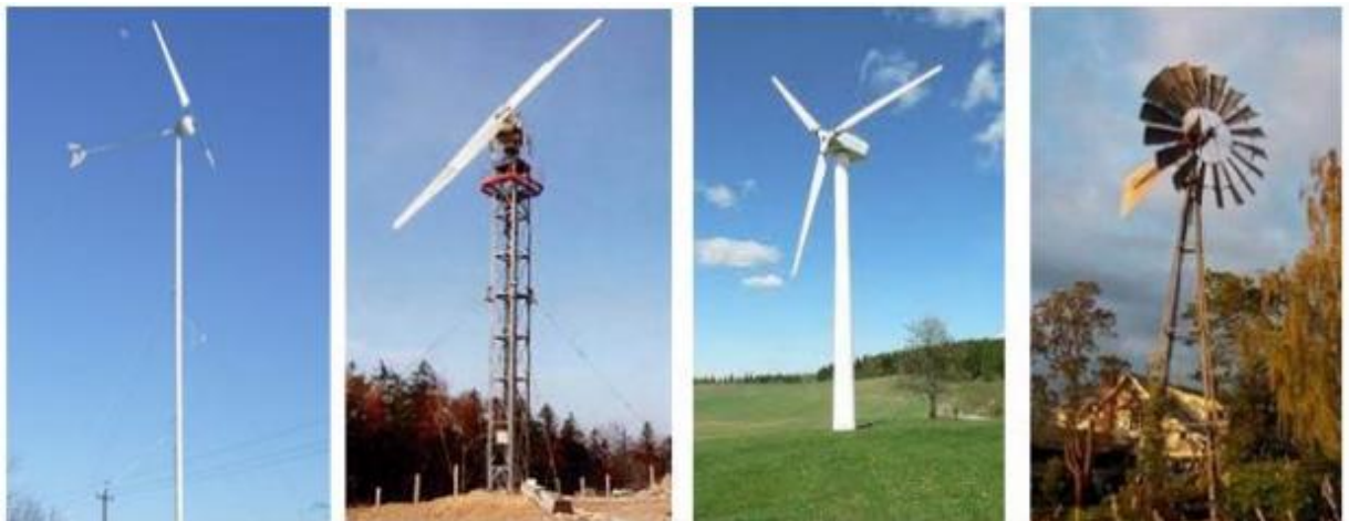
Рисунок 2.4 – ВЕУ з горизонтальною віссю обертання
