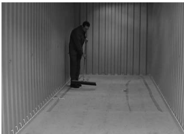
1. Підготовка контейнера до установки вкладиша
