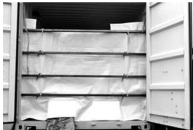
10. Монтаж установчого комплекту (утримуючі елементи, балки)
