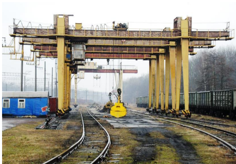
Рис. 6.1 - Перевантажувальний термінал на станції Мостиська II [15]
