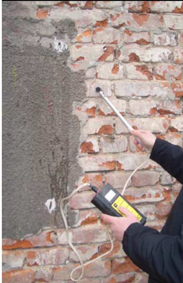
Рис. 2.1. Процес проведення натурних досліджень теплотехнічних характеристик зовнішніх огорожуючих конструкцій стіни будівлі
