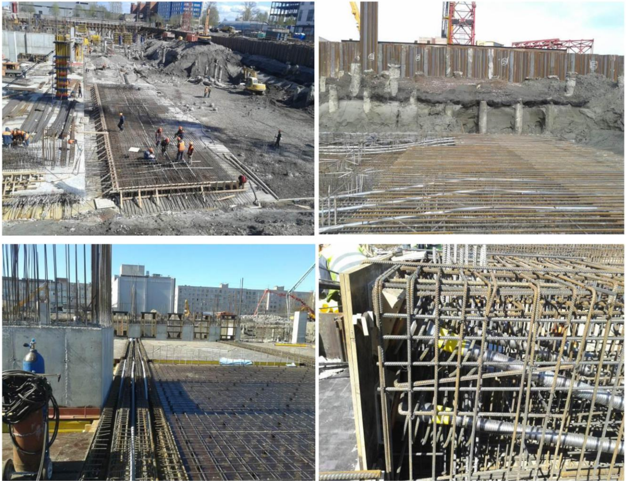
Рис. 1.4. Укладання гофрованих труб для канатів постнапруження
