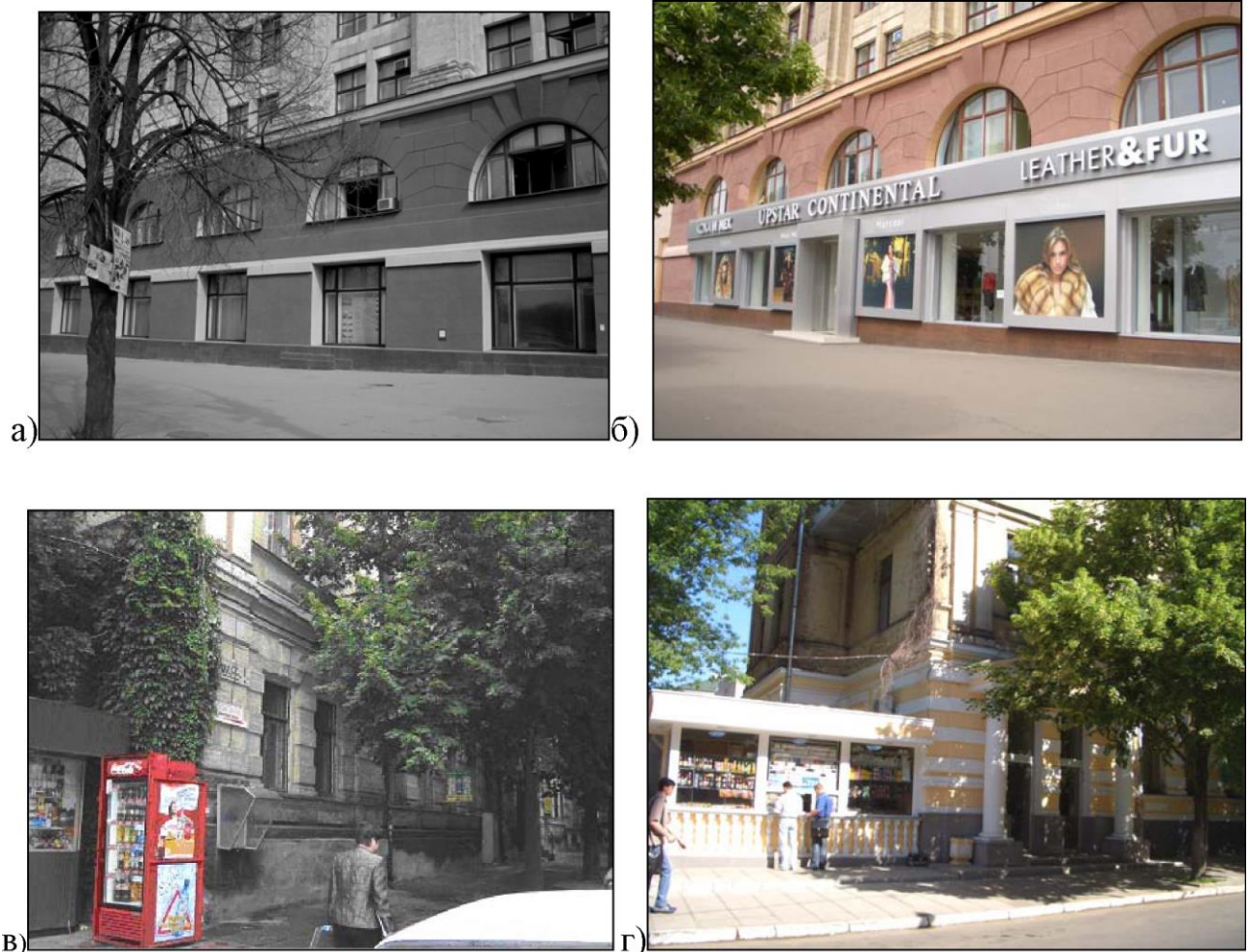
Рис. 1.1. Загальний вигляд окремих будинків, що реконструюються:
