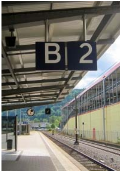
Рис. 7 – Позначки на платформі з вказівкою сектора
