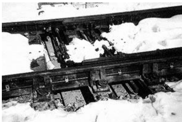
Рисунок 4.5 - Стрілочний обогрівач типа SwitchBlade корпорации Fastrax
