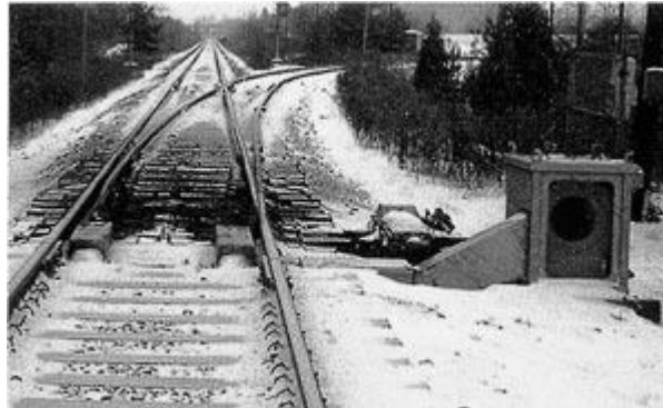
Рисунок 4.3 - Стрілочний обдувач типу Tempest корпорації Dirac-Delta Technologies
