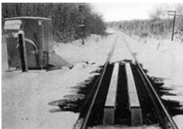
Рисунок 4.8 - Стрілочний обдувач типу НАС компанії Honey Industries
