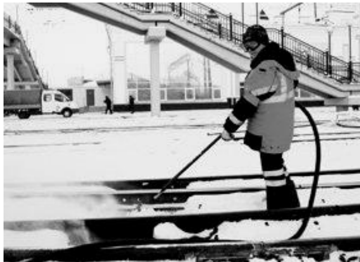
Рисунок 4.4 - Пристрій пневматичного шлангового ручного очищення
