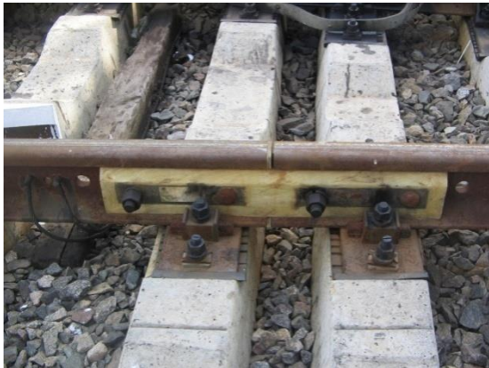
Рис.1.4 Залізничний стик з повнотілими накладками в зборі
