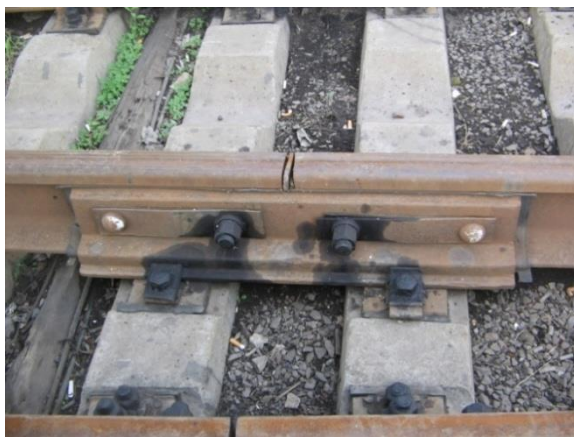
Рис. 1.2 - Осяжний залізничний стик в зборі
