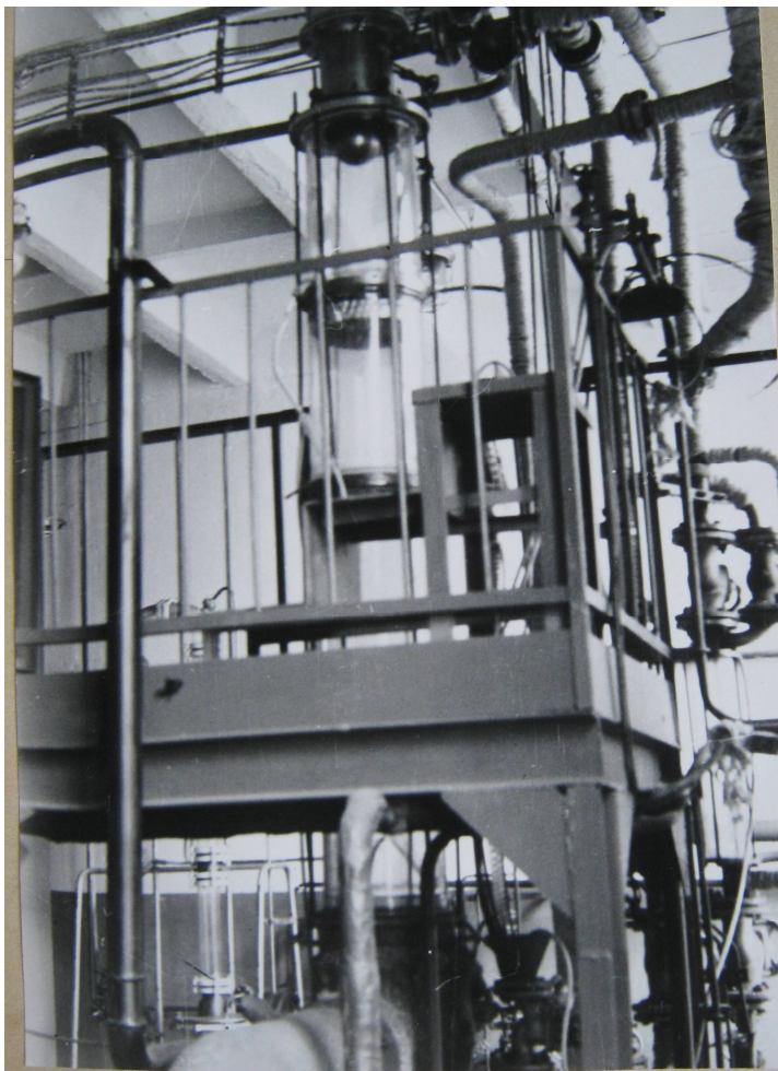
Рисунок 9 – Стенд ректифікації системи метанол–вода.
