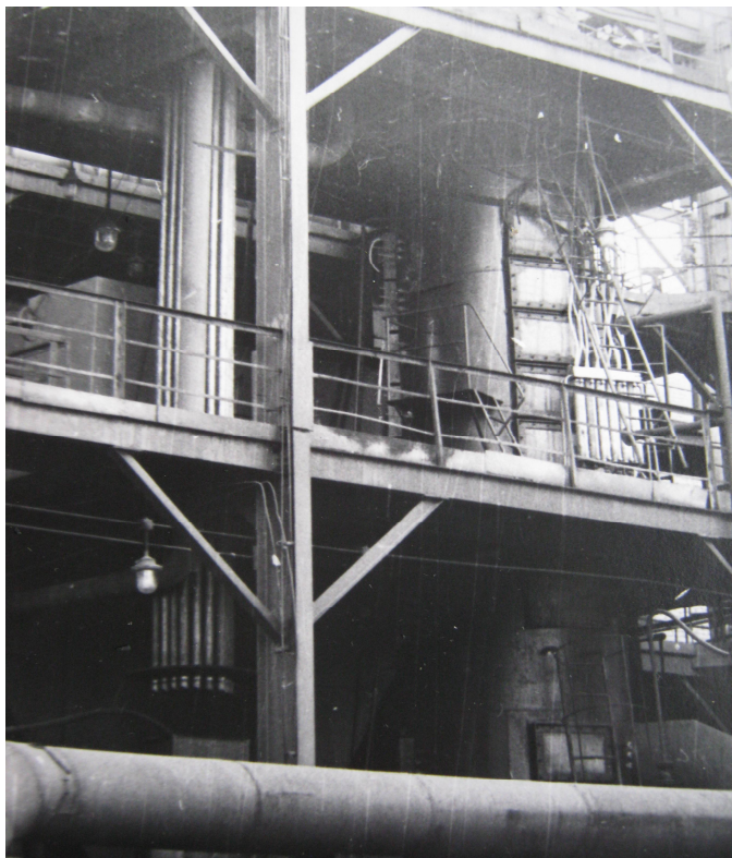
Рисунок 1 – Стенд гідравлічних випробувань з колоною D = 2 м.
