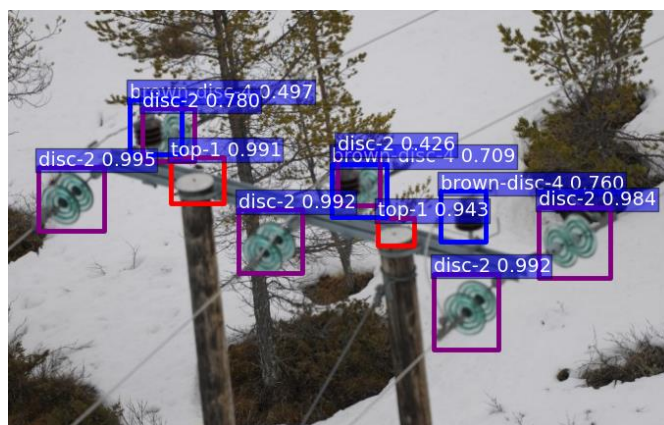
Рисунок 1.1 – Виявлення дронами пошкоджень на ЛЕП
