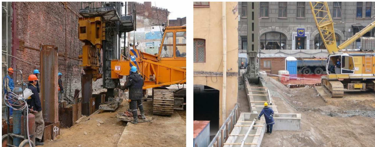
Рис. 1.2. Занурення шпунта і пристрій «стіни в ґрунті» біля існуючих будівель на об'єкті
