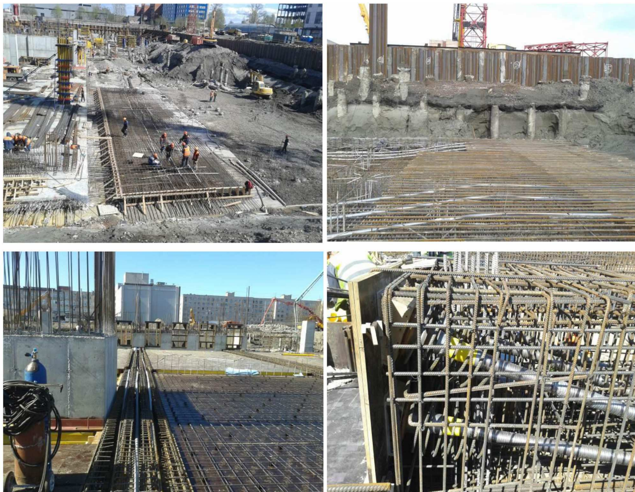
Рис. 1.4. Укладання гофрованих труб для канатів постнапруження
