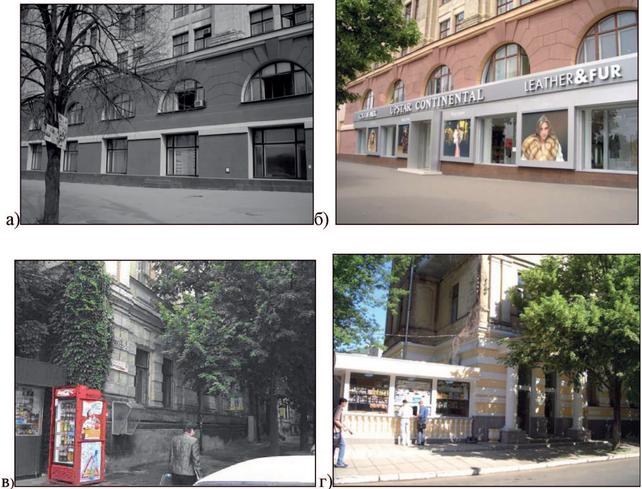
Рис. 1.1. Загальний вигляд окремих будівельних об'єктів до і після реконструкції: а, б – реконструкція адміністративних приміщень під торговий центр на площі Свободи; в, г – реконструкція житлових приміщень під кафе на вул. Мироносицькій;
