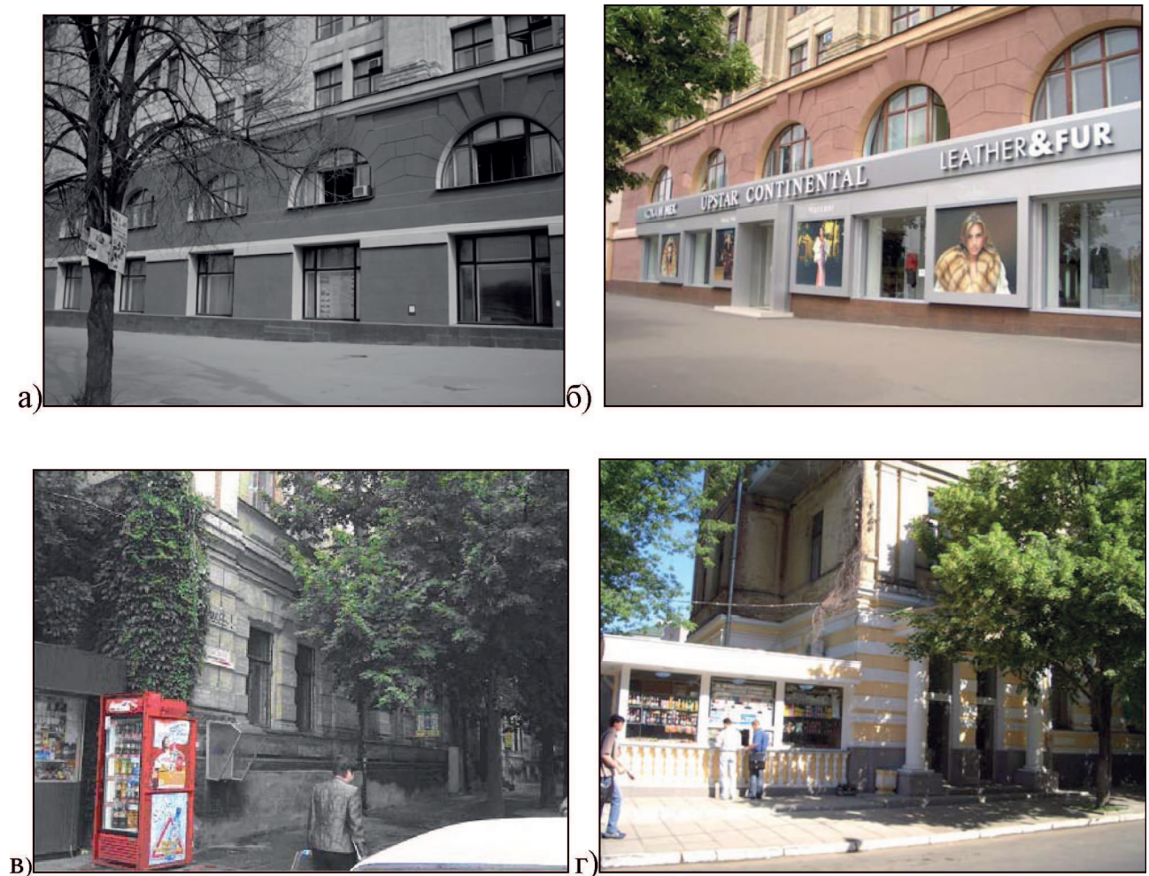
Рис. 1.1. Загальний вигляд окремих будинків, що реконструюються:
