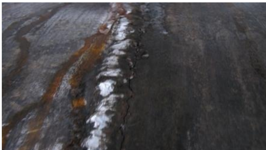
Рисунок 1.5 - Тріщина в місці ремонтного зварювання
